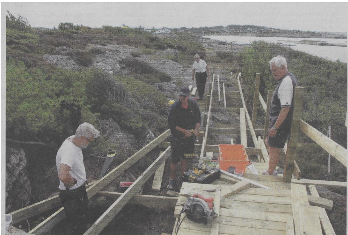
BYGGE. Meter för meter växer kustpromenaden fram längs Åsas stränder. Ett spännande projekt som många tycker till om. Här är det Mats Hedmar, Jan Hvit och Glenn Jansson som klurar på en lösning tillsammans med projektledaren Lars Ranäng.
